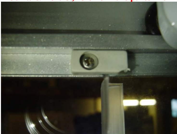
Schita 3/ Poza 3., Cleme fixare parte fixa
